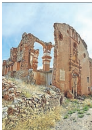
Estado actual del convento.
