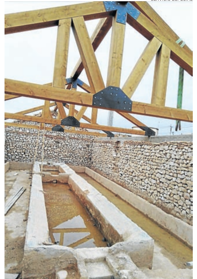
Se han mantenido las pilas pero se está renovando la cubierta.
